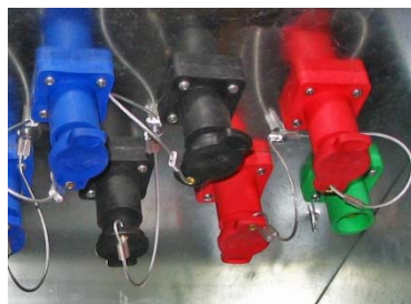
Conector Cam-Lok en las versiones móviles
